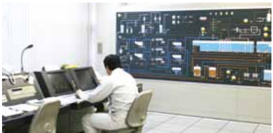
▲中央監視室では、工場内の機器の運転状況を確認します
