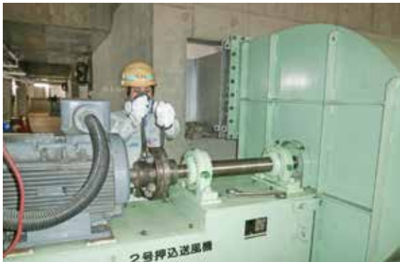
▲ 燃焼用空気を送る送風機の点検整備
