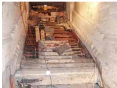
▲ 焼却炉内の火格子の交換
