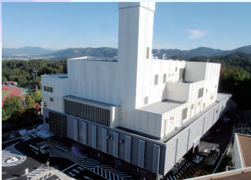
▲建設中の(仮称)新折居清掃工場。平成30年4月からの稼働に向け試運転調整を行っています。
