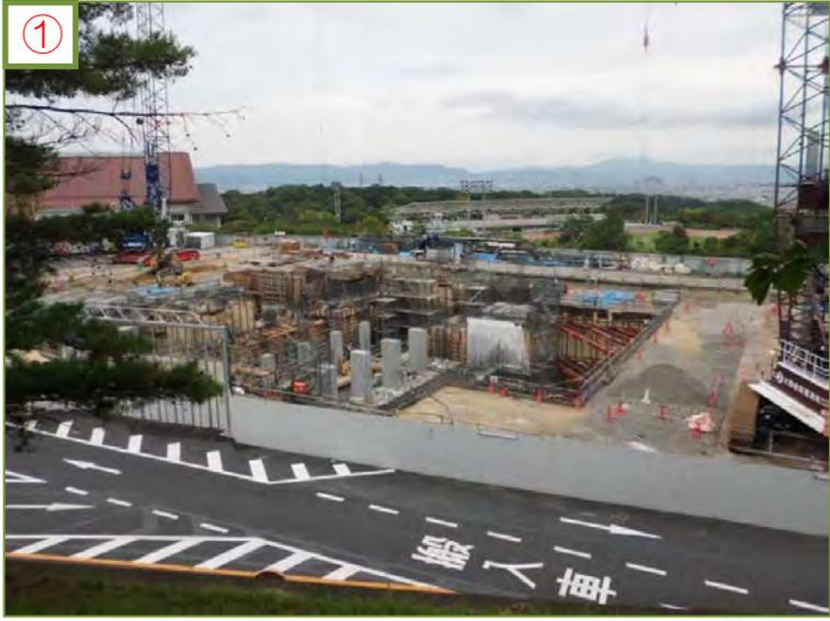
現在、建屋の地下部分の鉄筋コンクリート工事を行っています。
