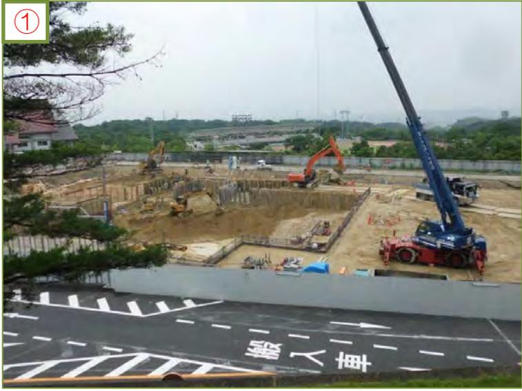
現在、土工事をしています。ごみピット等地下部分の掘削をする工事です。
