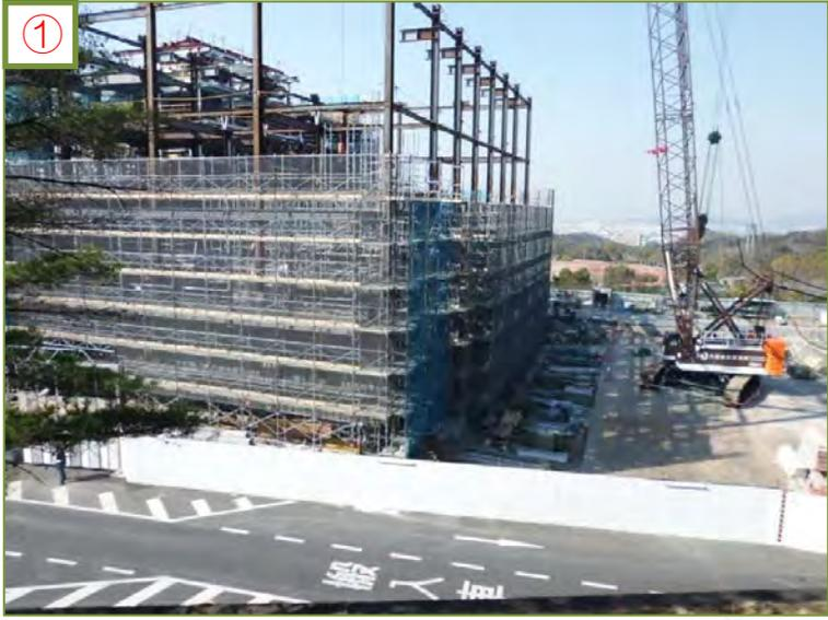
現在、1階～3階の外壁設置工事が進んでおり、併せて建屋内では各種設備室の間仕切り工事やプラント機器の設置も進んでいます。
