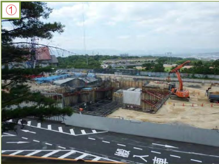
現在、建屋の地下部分については鉄筋を組みコンクリートの打設をしています。また最も深い部分であるごみピット部分の掘削もあわせて実施しています。
