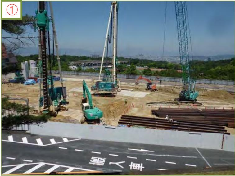
現在、山留工事をしています。山留工事とは掘削するとき、周辺の地盤が崩れないようにする工事です。
